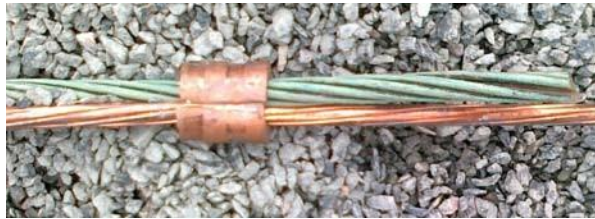
Figur 20. Skjøting av jordledning med C-press
