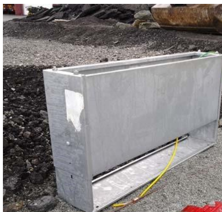
Figur 22. Innføring av isolert jordledning i kabelskap
